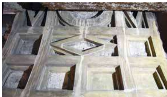
7. Casa di Augusto, oecus principale, resti del soffitto, in gran parte reintegrati nel restauro.
