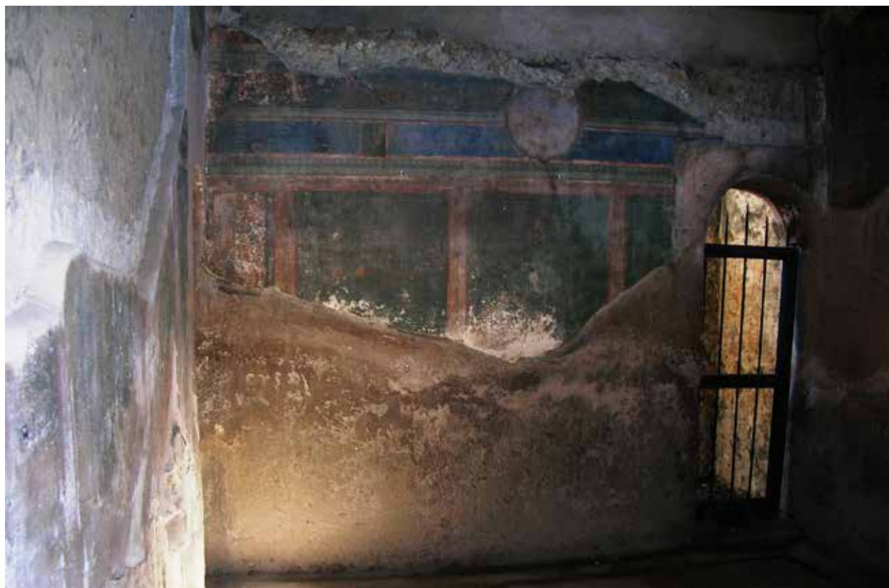
1. Front wall of the apodyterium of the Casa dell'Albergo.
