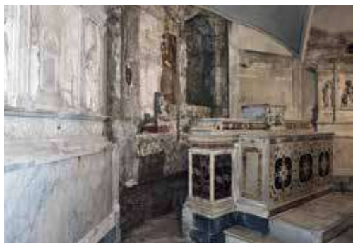
5. Il muro in opus vittatum con andamento curvilineo (dal basso verso l'alto).
