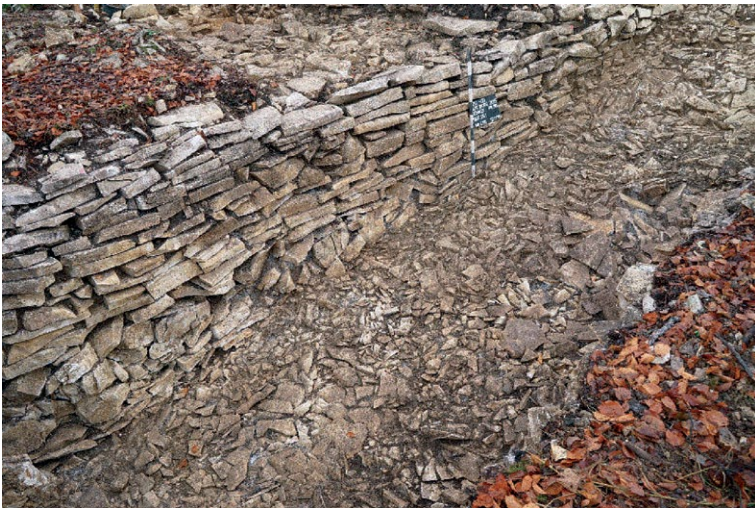
Fig. 8. Contrafforte murario presso il margine nord-ovest del pianoro della Alte Burg (LAD im RP Stuttgart).
