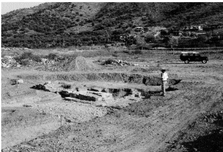
Fig. 4. Phoinike: panoramica dell'«altare» e del muro di contenimento del piccolo terrazzo superiore.
