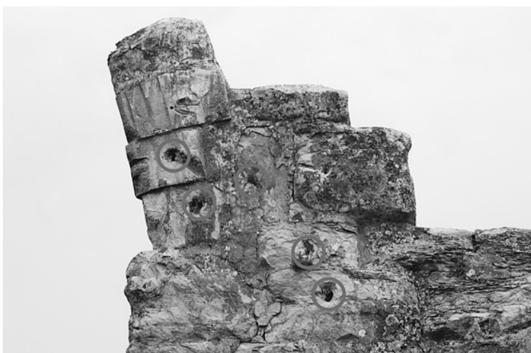
Fig. 16. Burnum. Fori nella muratura per il sollevamento dei conci.
