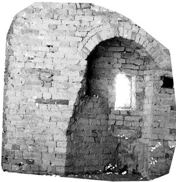
Fig. 10. Acquaviva Picena. Facciata interna della torre sud della Fortezza. Ortofoto della feritoia.
