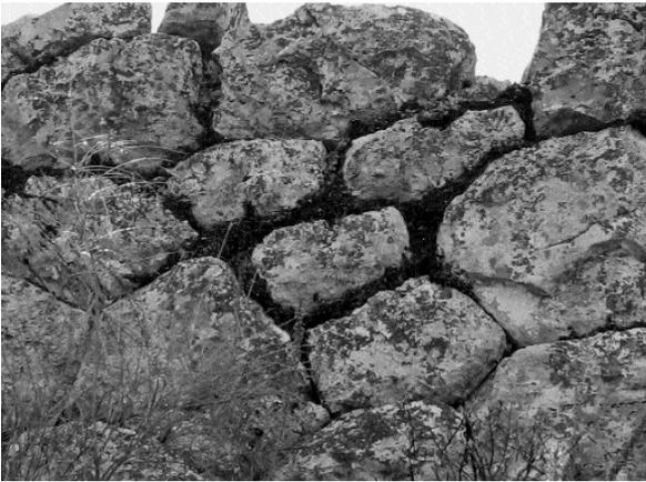
Fig. 10. Opera poligonale irregolare.
