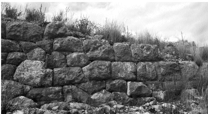
Fig. 14. Passaggio da poligonale a trapezoidale (tratto T8b).
