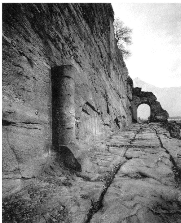
Fig. 25. Via della Valle d'Aosta, Donnas, taglio in roccia con miliario e arco dimostrativo del lavoro svolto.
