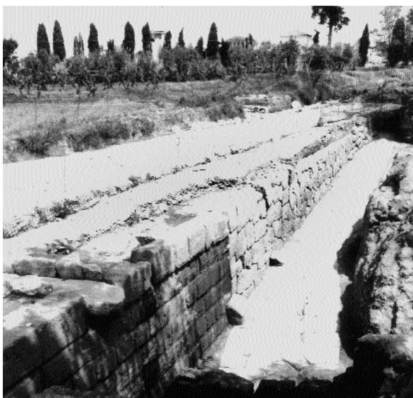
Fig. 3. Via Appia, Mondragone, viadotto in sovrapposizione a un tracciato più antico.
