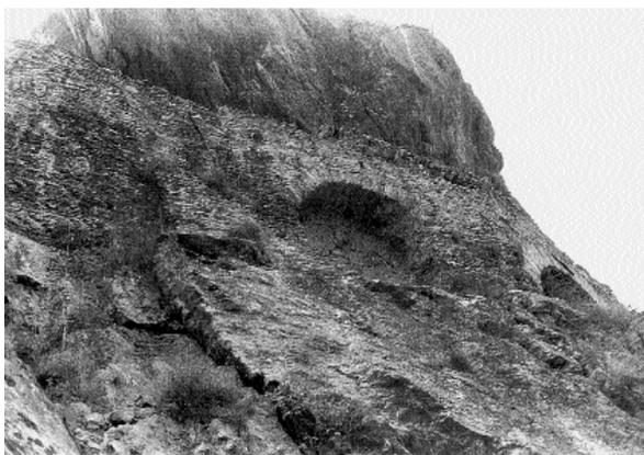
Fig. 23. Via della Valle d'Aosta, terrassanti di sostegno alla strada alla Pierre Taillée.
