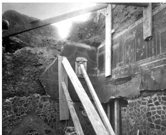
Fig. 12. La foto realizzata durante lo scavo della Casa del tramezzo di legno testimonia la necessità di puntellare la parte alta delle pareti per poter intervenire sulla parte bassa, fortemente danneggiata dai flussi vulcanici (Arch. SAP C2365 del 1928) (su concessione del Ministero per i Beni e le Attività Culturali - Soprintendenza Archeologica di Pompei).
