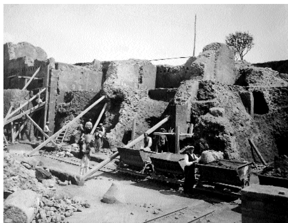
Fig. 7. Il faticoso procedere degli scavi all'incrocio tra decumano inferiore e V cardo. Si individua la ferrovia a vagoncini utilizzata per portare la terra degli scavi fin sul litorale di Ercolano (Arch. SAP C2552 del 1932) (su concessione del Ministero per i Beni e le Attività Culturali - Soprintendenza Archeologica di Pompei).
