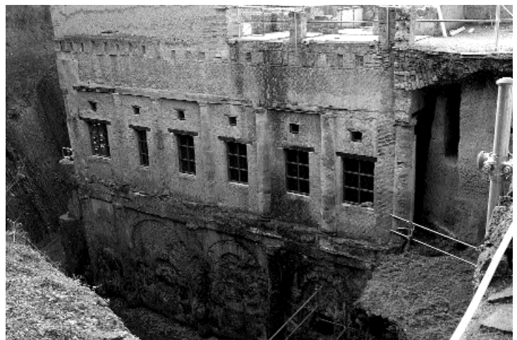
Fig. 10. Veduta del prospetto orientale della cd. Ala meridionale della Casa del Rilievo di Telefo: le finestre chiuse dai telai lignei sono quelle del primo piano inferiore (foto di M.P. Guidobaldi, SAP).
