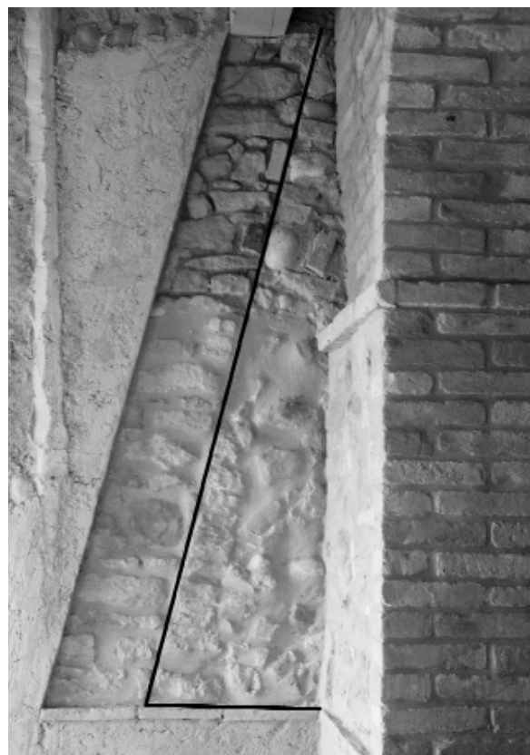
Fig. 10. Circuito murario di Acquaviva Picena: sezione occasionale delle mura della Terra Nuova in un cantiere edile presso l'Ex-Ospedale di Sant'Anna. Si noti la cortina muraria con andamento a scarpa evidenziata dalla linea nera.
