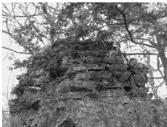
Fig. 6. Particolare della specchiatura in opera laterizia della pila n. 2.
