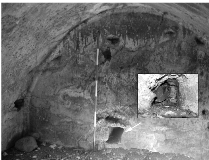
Fig. 18. Il condotto più piccolo nella parete occidentale della cisterna.
