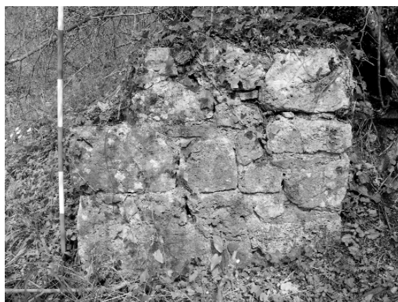
Fig. 8. La pila n. 5 in affioramento dal fosso delle Colonnette.
