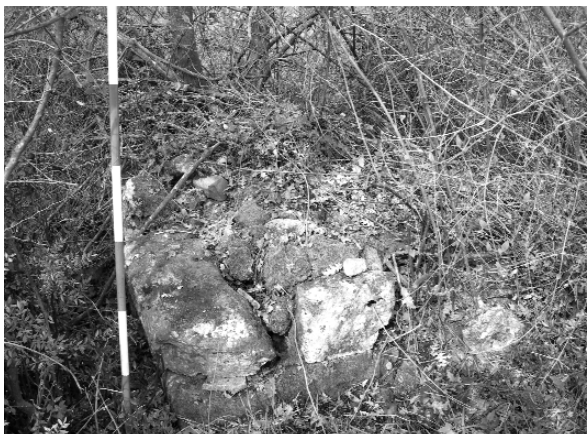
Fig. 10. La pila n. 11 seminascosta dalla vegetazione, da est.
