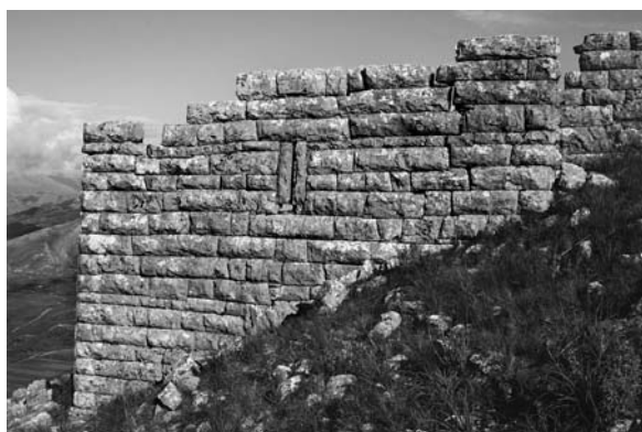
Fig. 3. Facciata settentrionale della torre di Vagalati (SA040). Foto SITARC 2007.
