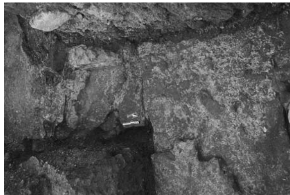
Fig. 15. Il muro perimetrale nord della basilica rinvenuto nel 2009. In evidenza la fondazione perpendicolare in blocchi di rosso di Verona, legata al muro perimetrale.
