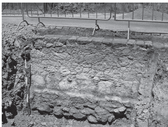
Fig. 3. Albinia, strada vicinale per Patanella. Parapetto di contenimento della via Aurelia antica.
