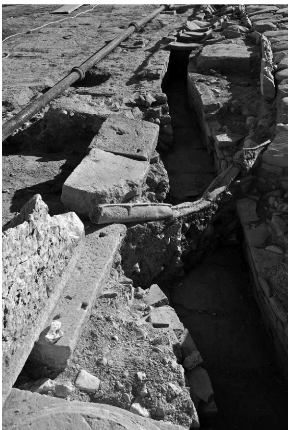
Fig. 13. La fistula USm 71 e la canaletta USm 68 vista da nord.
