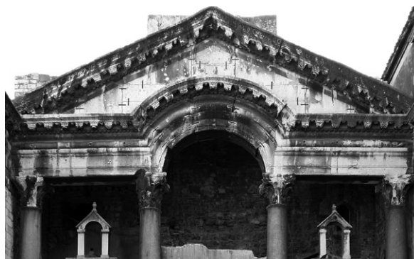
Fig. 31. Detalle de la fachada del llamado "peristylum" del palacio de Diocleciano, Split (Radoslav Bužančić).
