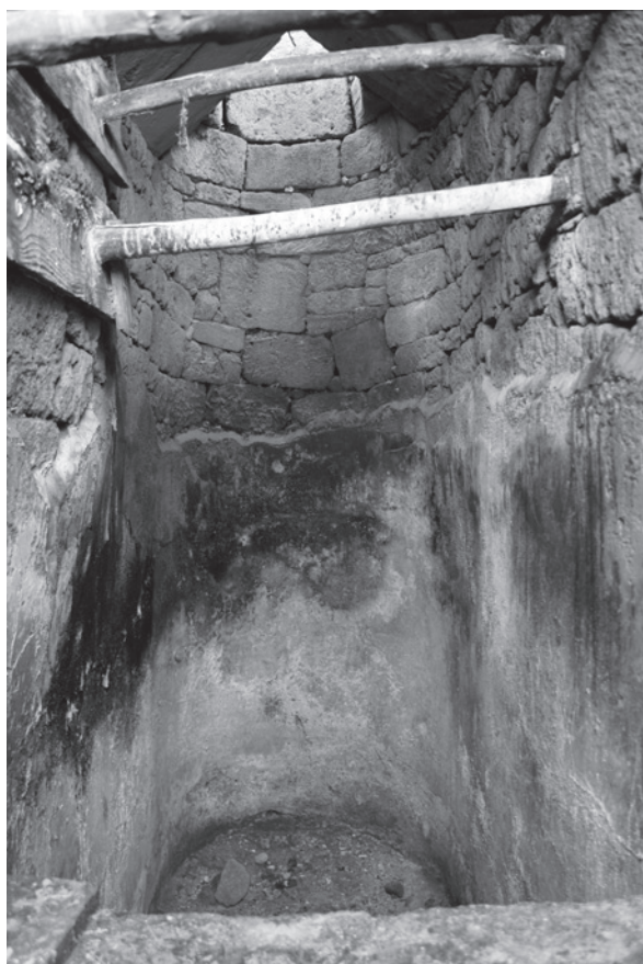
Fig. 6. Stato di conservazione dell'intonaco impermeabilizzante del settore meridionale della cisterna nr. 8 (fotografia di M. Marano)
