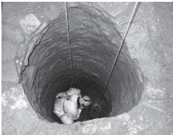
Fig. 3. Scavo del pozzo
