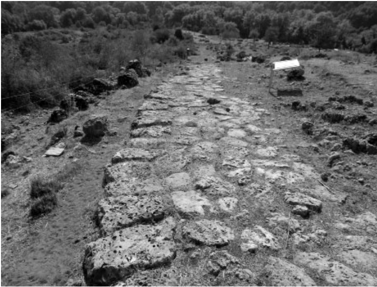
Fig. 15. Pavimentazione in lastre di pietra della strada (o) di Gitana (foto dell'Autore)
