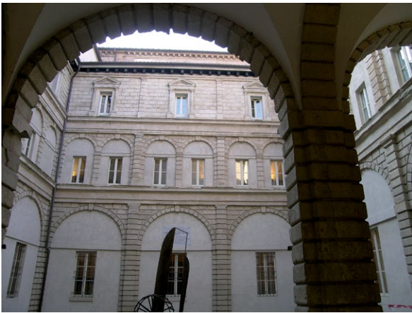
Fig. 7. Il chiostro piccolo cd. "alla rustica" (foto M.T. Guaitoli).
