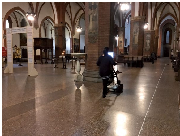
Fig. 1. Una fase del survey georadar all'interno della chiesa.
